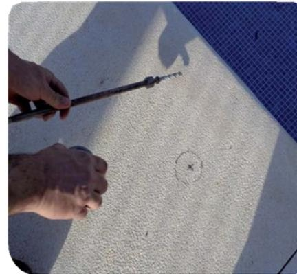
*Trépan diamètre 68mm*
