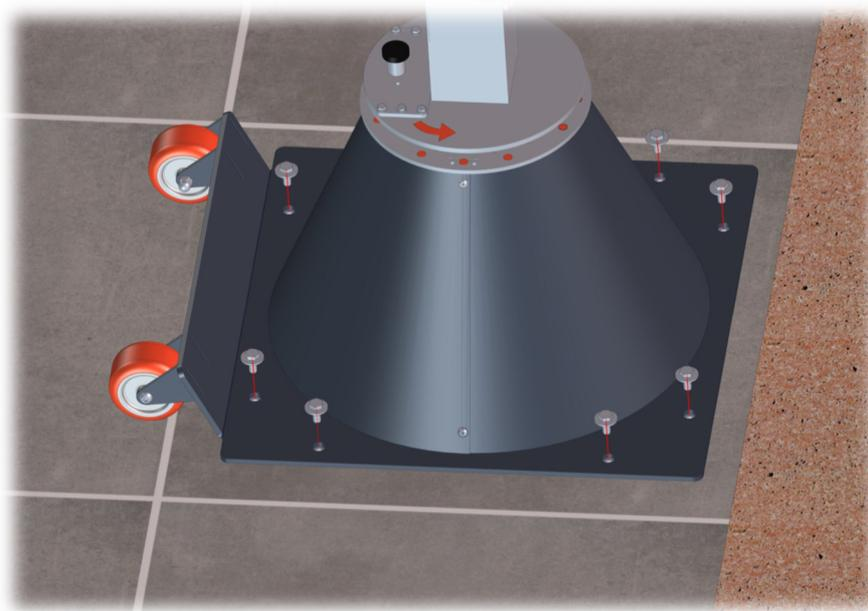
**Paso 7.** Una vez secado el anclaje químico EPOXI realizar un apriete intenso de los tornillos de los tacos del anclaje.
